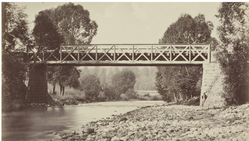
(Novostavba mostu Severozápadní dráhy přes Labe mezi Dolní Brannou a Kunčiči nad Labem, foto Josef Löwy)
