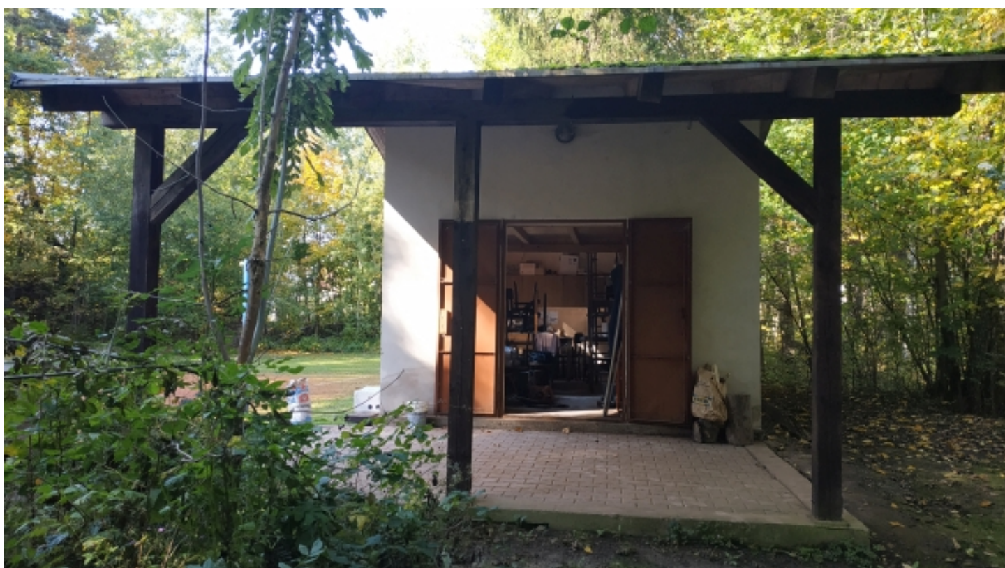
9. márnice - pravá strana
