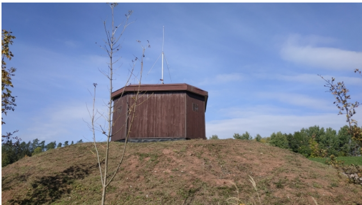
7. vodovod vodojem - zadní strana
