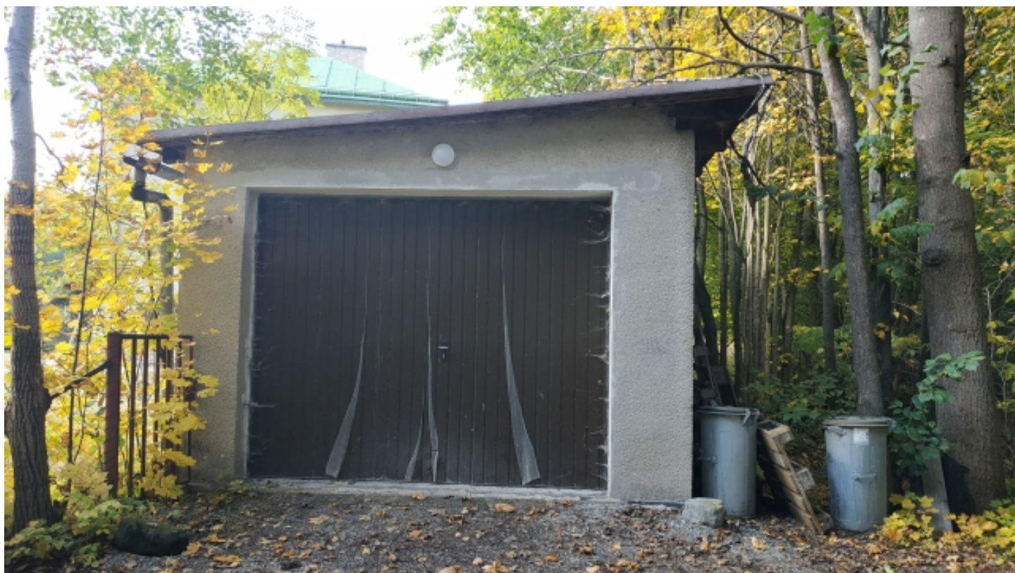
7. vodovod vodojem - pravá strana
