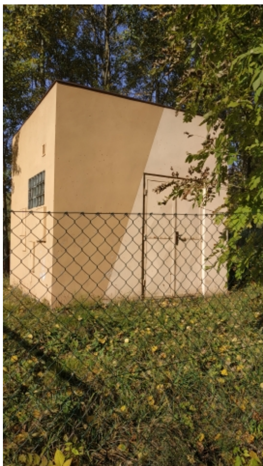
6. vodovod čerpací stanice - přední strana
