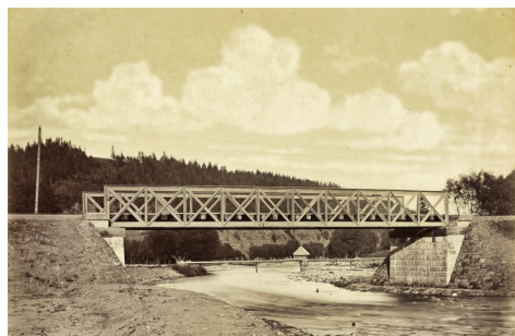
Novostavba mostu Severozápadní dráhy přes Labe mezi Kunčicemi n. L. a Klášterskou Lhotou, foto Josef Löwy
